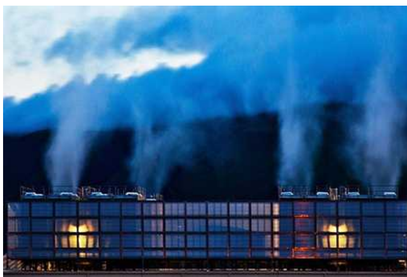
Google data centre. Foto: Green Queen
