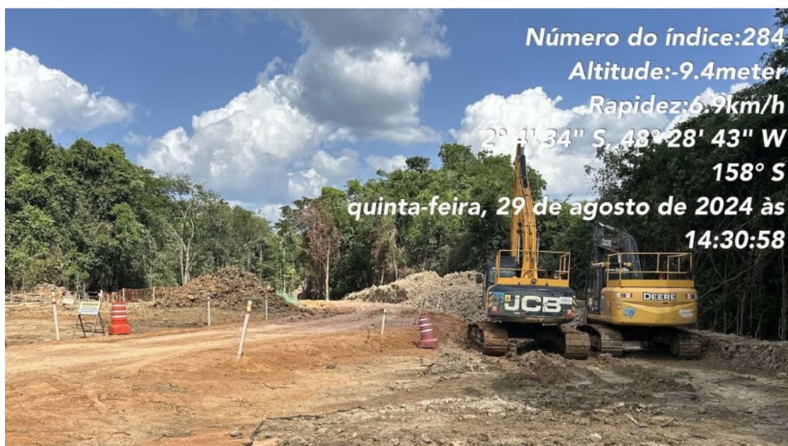
Obras del mineroducto de Hydro para transportar bauxita en la Amazonía brasileña (Foto: Movimiento IRQ)
