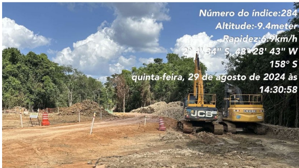
Travaux du minéroduct de Hydro destiné au transport de bauxite en Amazonie brésilienne (Photo : Mouvement IRQ)
