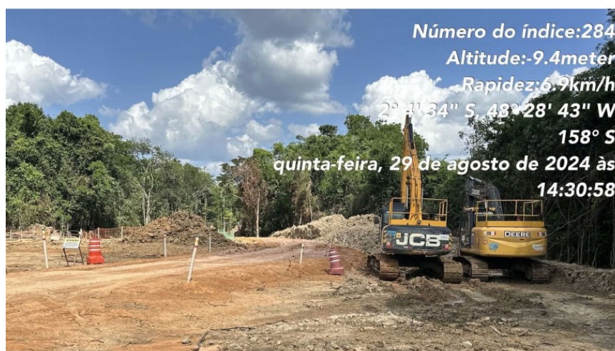
Obras do mineroduto da Hydro para transportar bauxita na Amazônia brasileira (Foto: Movimento IRQ)
